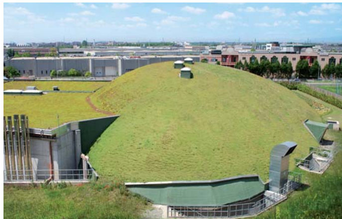
Die „kleine“ Kuppel im Fokus – die extremen Dimensionen der Dachbegrünung sind gut zu erkennen: Dachneigung und Entwässerungslängen.
