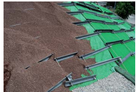
Struktur-Speichervlies SSV 800 und Schubsicherungssystem Seil-Schwelle sind verlegt, teilweise schon mit Extensivsubstrat verfüllt.
