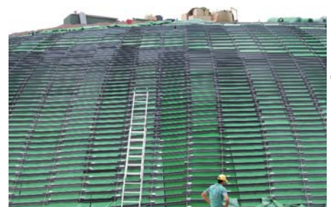
In der Bauphase war die steile Dachneigung noch krasser zu sehen.
