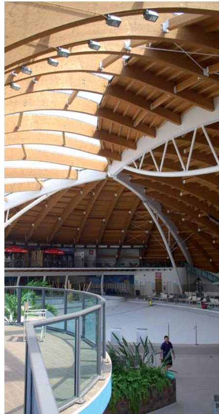
Die Holzkonstruktion von unten betrachtet. Dort wo es dunkel ist, liegt die Dachbegrünung drüber.
