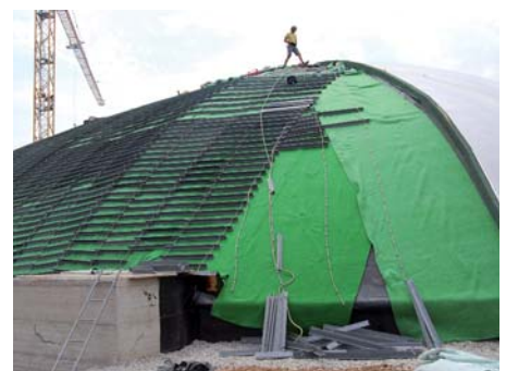
Das Optigrün-Schubsicherungssystem Seil-Schwelle beim Einbau
