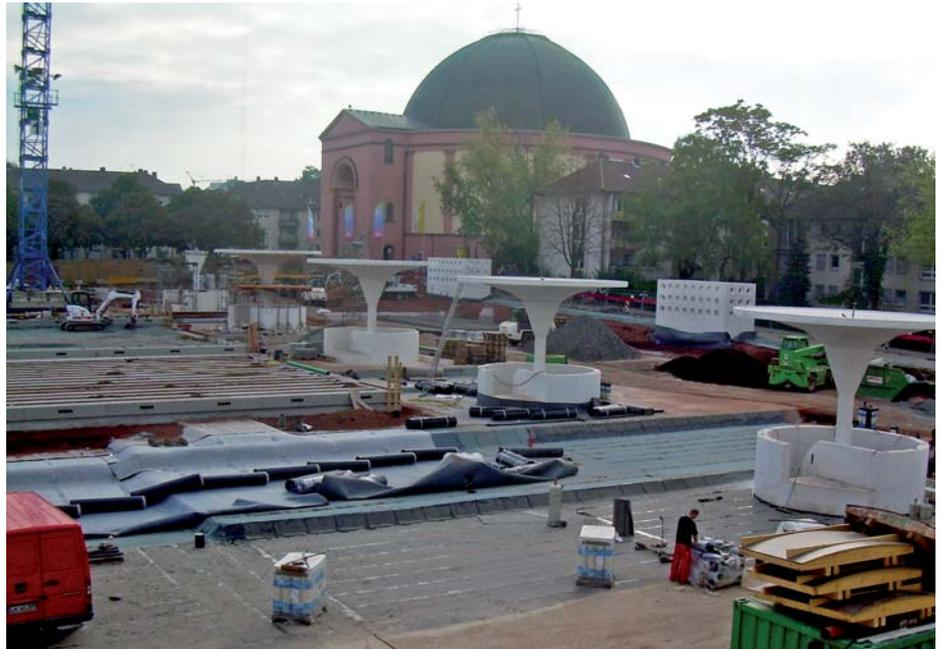
Blick auf die Baustelle: Verlegung der Schutzlage RMS 1200 und Festkörperdränage FKD 12
